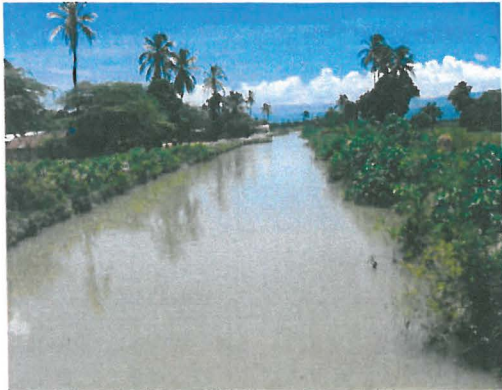
Canal d'irrigation qui alimentait la population de Fossé-Naboth, en eau de consommation
